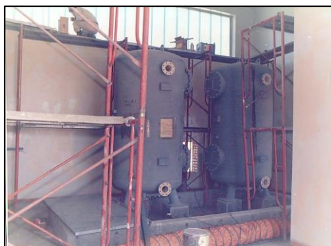
شکل ۱۵-۲ مخزن‌های اسید و سود نیروگاه طوس- مشهد، تصویر از: نویسنده (سمت چپ) و فرآیند شستشوی معکوس رزین‌های تبادل یونی (سمت راست).
