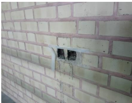
شکل ۸-۹ ضرورت اجرای ایمنی در دیوار پشتی دروازه سالن ورزشی (سمت راست) و پریزهای برق خطرناک (سمت چپ) (تصویر: نویسنده).
