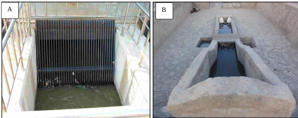
شکل ۲-۱۷ تصاویری از آشغال‌گیرها. (A) آشغال‌گیر میله‌ای مکانیکی و (B) دو نوع آشغال‌گیر میله‌ای مکانیکی و آشغال‌گیر مثلثی (عکس: نویسنده، تصفیه‌خانه وتلند (نیزار) روستایی کلات گناباد-خراسان رضوی).
