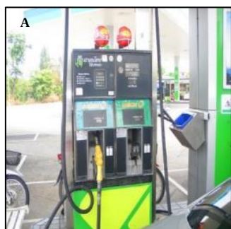
شکل ۷-۲۱ برخی از فناوری‌های جدید کنترل حریق: (A) توپک‌های خاموش‌کننده در پمپ بنزین، (B و C) ربات‌های آتش‌نشان.
