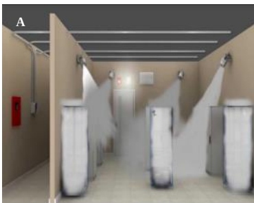
شکل ۶-۷ اطفای آئروسول: (A) سیستم اطفای آئروسول و (B) مخازن آئروسول با نام تجاری پایروژن در اندازه‌های مختلف.
